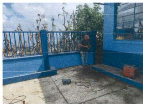
Foto 4: Sustitución de baranda de metal en la pared frente el centro educativo
