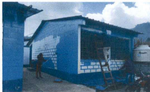
Foto 8: Pintura del exterior de todas las aulas 1, 2, 3, 4, 5, 6, 7, 8, 9, 10.
