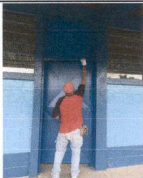
Foto1: Pintura de puertas de metal en las aulas 1, 2, 3, 4, 5, 6,
