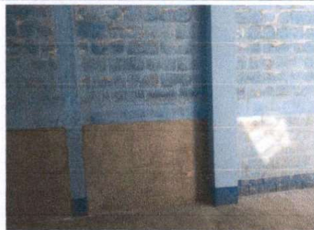
Foto 6: Repello y alisado de pared del aula 10 que tenía filtración de agua .
