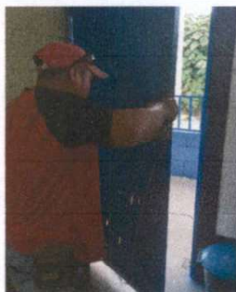
Foto7: Sustitución de chapa de la puerta de la dirección.
