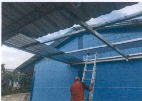
Foto 9: Instalacion de techo con estructura de metal sobre la pila.
