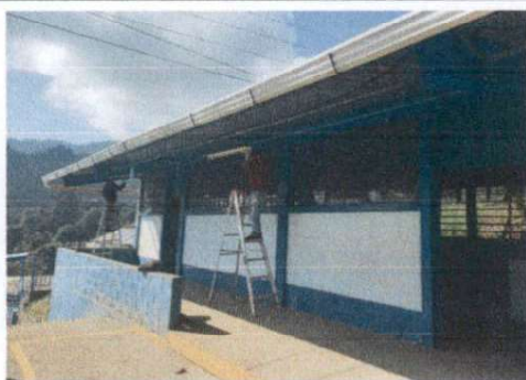
Foto 5: Colocación de Cable e instalación de lamparas y tomacorrientes en las aulas 1, 2, 3, 4, 5, 6 y corredores
